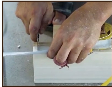
Bước 1: Cắt khung bao đúng theo chiều cao đo đạc Step 1: Cut the frames as the measured height.
