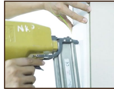
Bước 3: Bắn miếng bọt lên tường, sử dụng thước bắn laze, đảm bảo các miếng bọt được bắn thẳng hàng theo chiều đứng Step 3: Attach the pads into the wall with the laze ruler, make sure to attach the pads in a straight vertical line.
