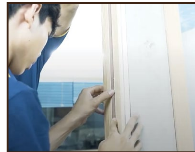
Bước 9: Lắp ron giảm chấn, giảm tiếng ồn cho cửa Step 9: Install the plastic seal to damp and soundproof.
