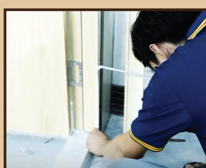
Bước 10: Đo cắt nẹp viền và gắn nẹp vào khung bao
