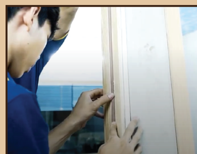
Bước 9: Lắp ron giảm chấn, giảm tiếng ồn cho cửa
