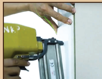
Bước 3: Bắn miếng bọ lên tường, sử dụng thước bắn laze, đảm bảo các miếng bọ được bắn thẳng hàng theo chiều đứng
